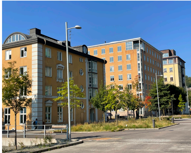
Karaktären i planområdets norra del kommer att förändras kraftigt i och med omgestaltningen av Tornen. På fotot syns Gothia, Tornen och Citadellet med gula putsade fasader, fotograferade från sydost.
