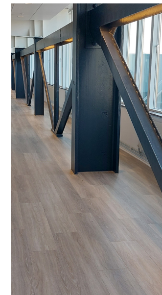
Detalj i interiör M2an, som inte omfattas av varsamhetsbestämmelse.
