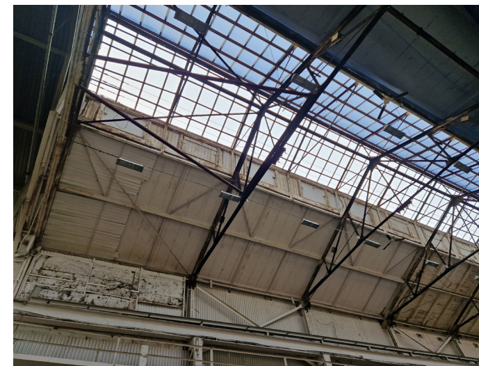
Taklanternin och takkonstruktion i Pannverkstaden.
