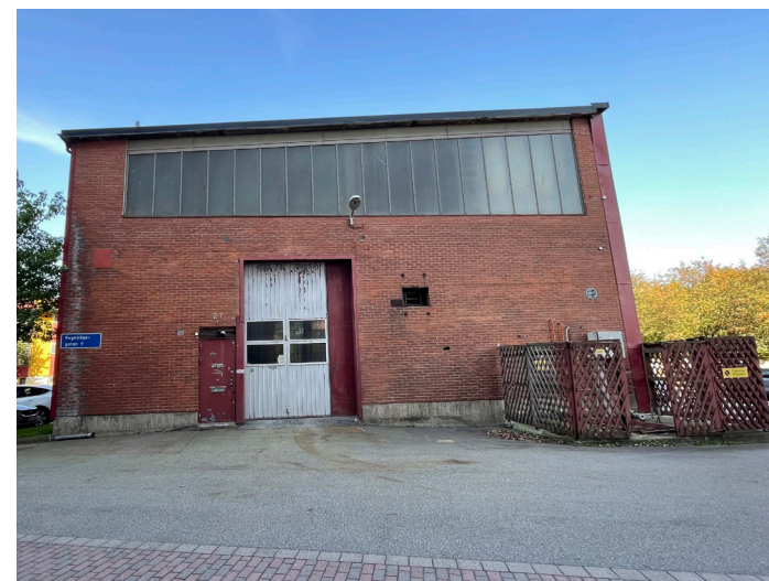
Härderiets södra fasad.
